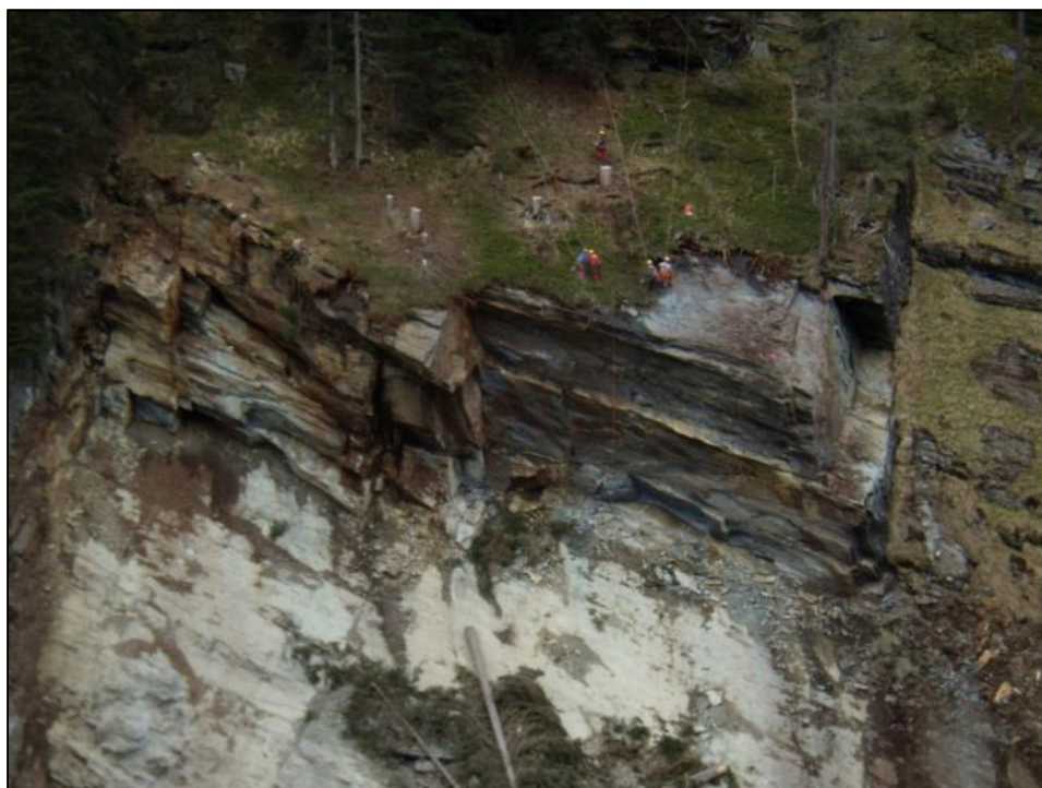
Abb.6: Abbruchstelle und basale Gleitbahn, Herstellung Sprengbohrlöcher, am 15.05.2013
