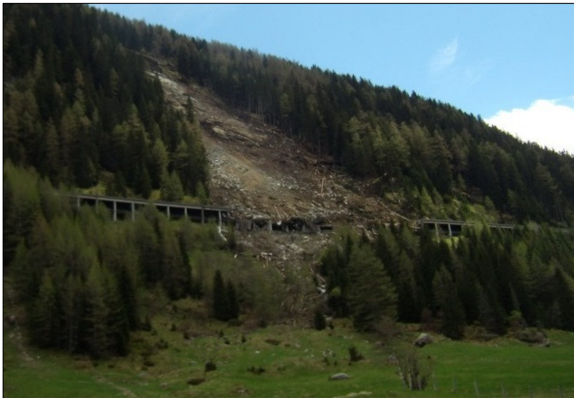
Abb.2: Übersicht Felssturz, Blick Richtung SE, 15.05.2013
