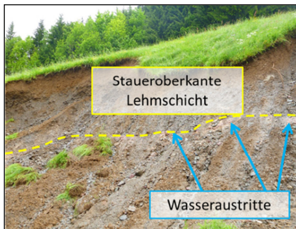
Abb. 2 Stauer mit Wasseraustritten
