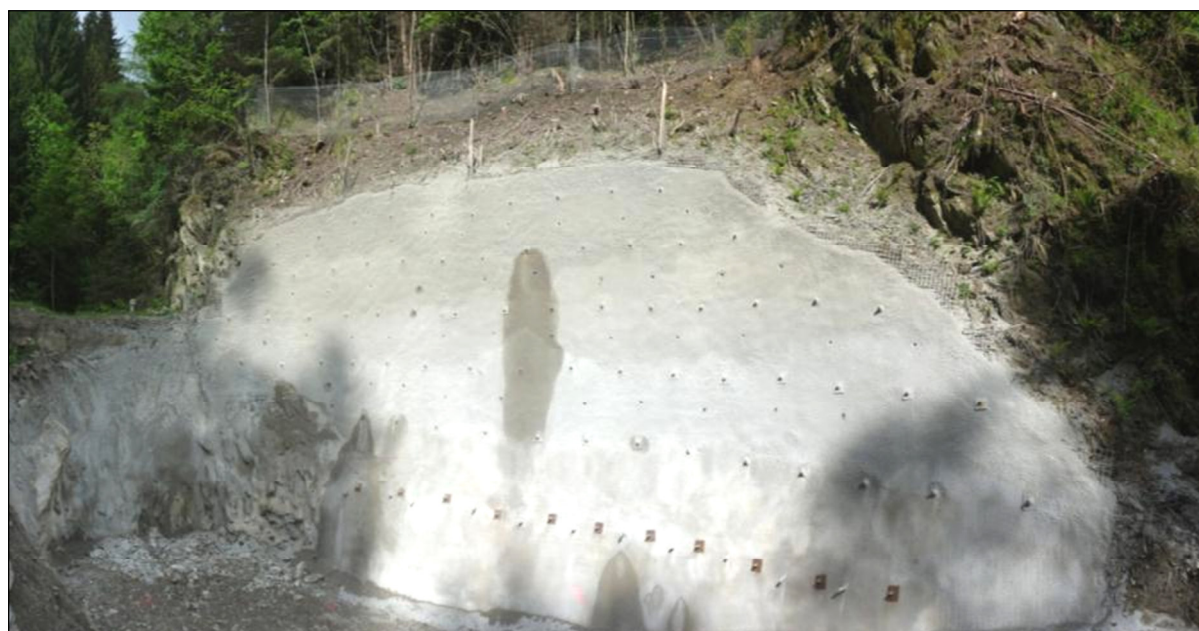
Abbildung 45: Fertiggestellte Baugrube mit geänderter Baugrubensicherung
