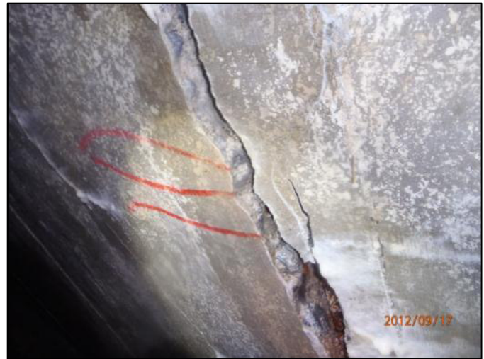
Abbildung 4 und 5: Riss in der Decke, Detail eines Risses mit abgerissener Bewehrung
