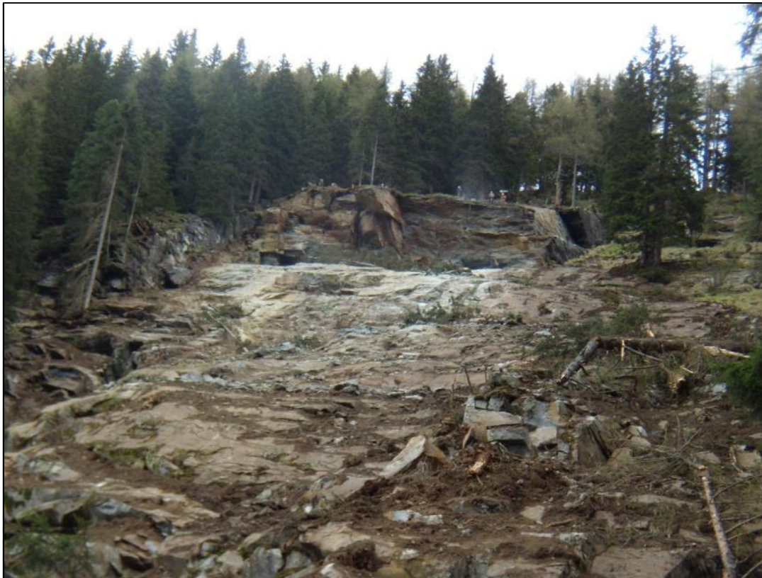
Abb.4: Übersicht Abbruchstelle Felssturz und Gleitbahn, Blick nach E, am 15.05.2013
