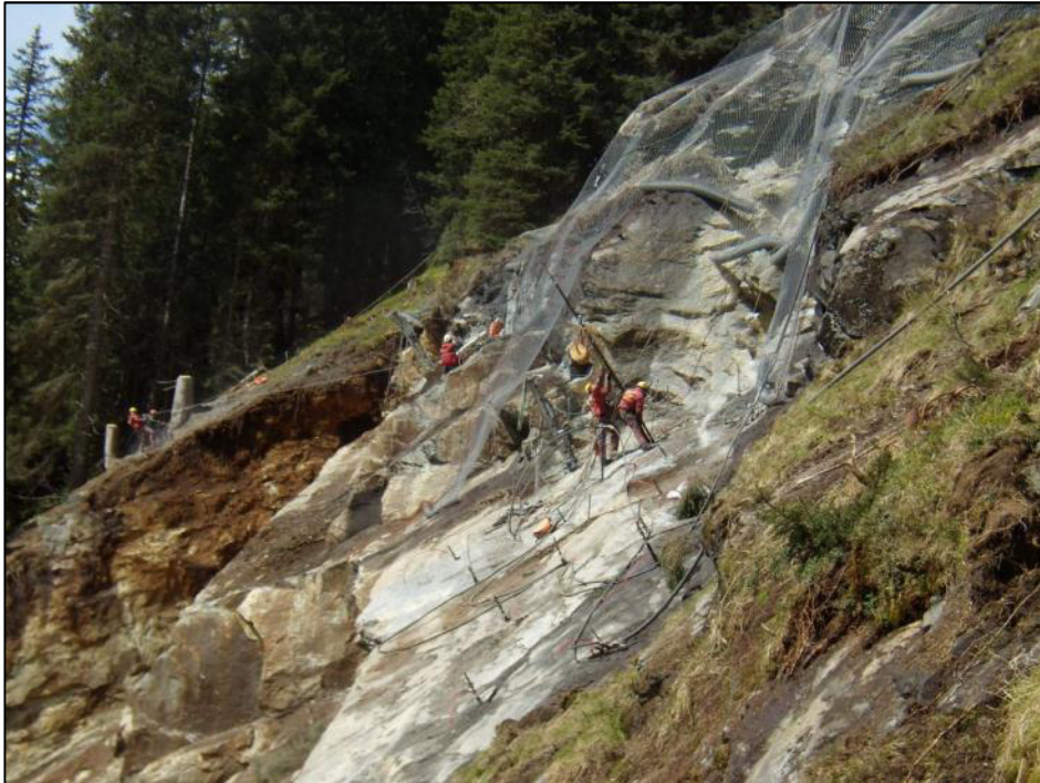
Abb.9: Einbau Felsanker am 29.05.2013, Blick nach N
