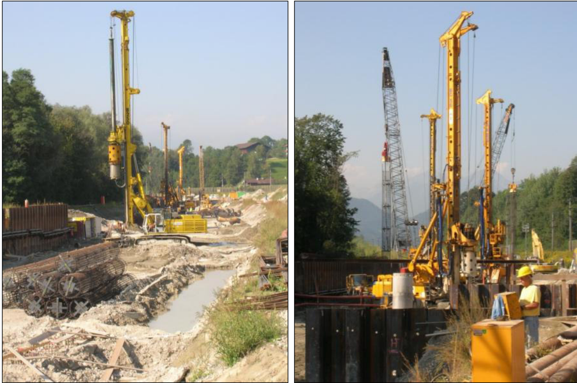
Abbildung 31: Sonderbaumaßnahme Deckelbauweise im Bereich Los H7 (Abschnitt Fritzenser Bogen, Bahnhof Fritzens)
