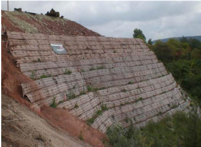
Bild 49: Fertige Wand nach Herstellung
