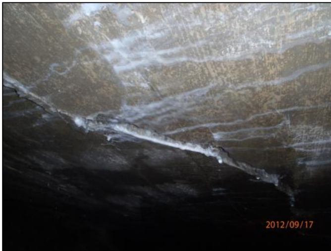
Abbildung 4 und 5: Riss in der Decke, Detail eines Risses mit abgerissener Bewehrung
