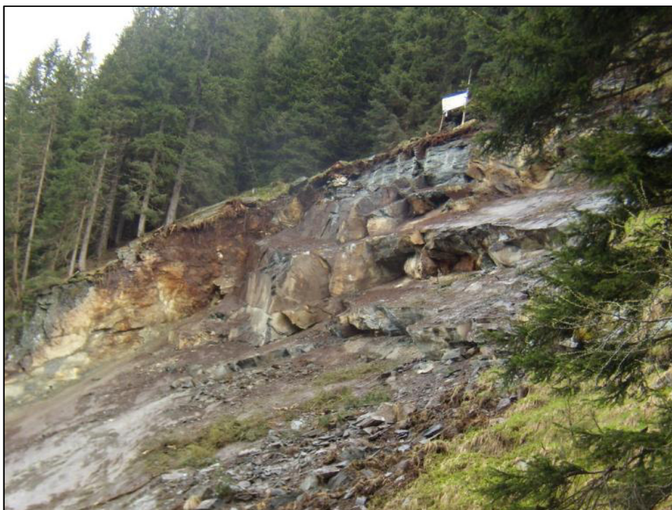
Abb.8: Abbruchstelle nach 2. Sprengung am 19.05.2013, Blick nach NE
