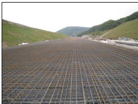
Bild 42: Bewehrung Erdfall- schutzplatte
