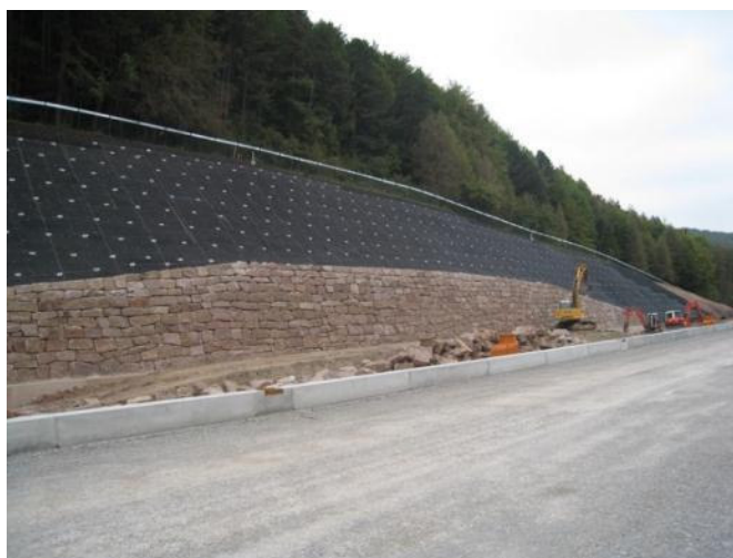
Bild 36: Stützkonstruktion an BAB A38 Egelskopf
