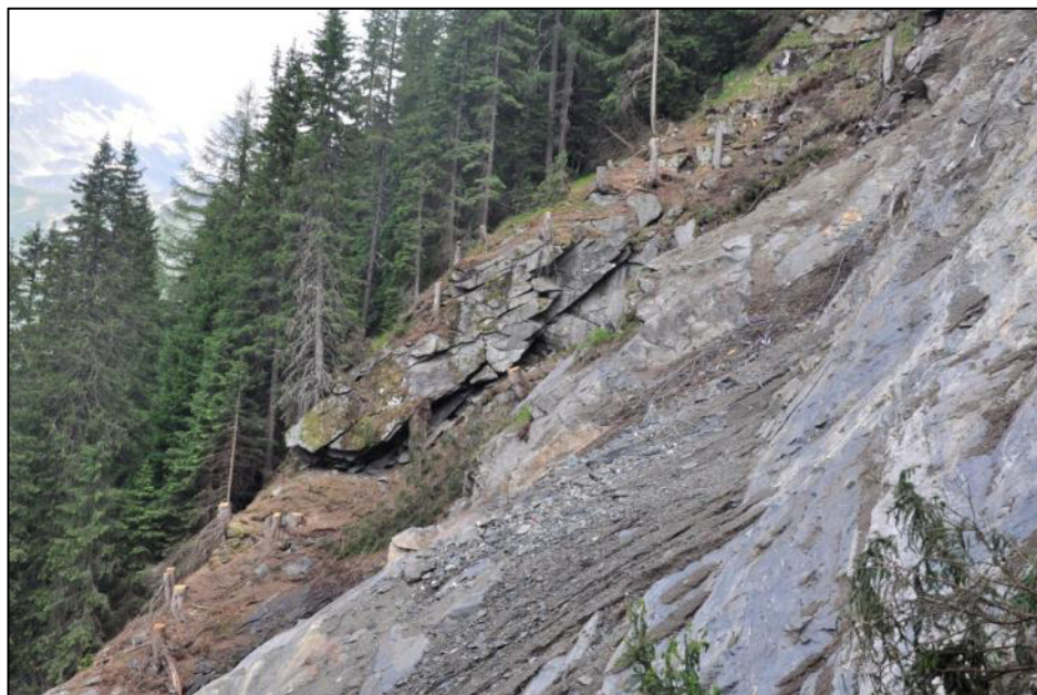
Abb.11: Unterer Bereich Nordflanke, stark zerlegter Felsabschnitt wurde sprengtechnisch abgetragen, Blick nach N, am 11.07.2013
